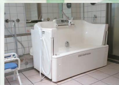
1階 大浴場:男浴室内 介護浴槽 (男女兼用・個浴)
